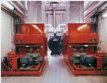
*Quatre cellules supplémentaires — toutes alimentées par la chaudière existante — peuvent être ajoutées au système pour en augmenter la capacité.*
